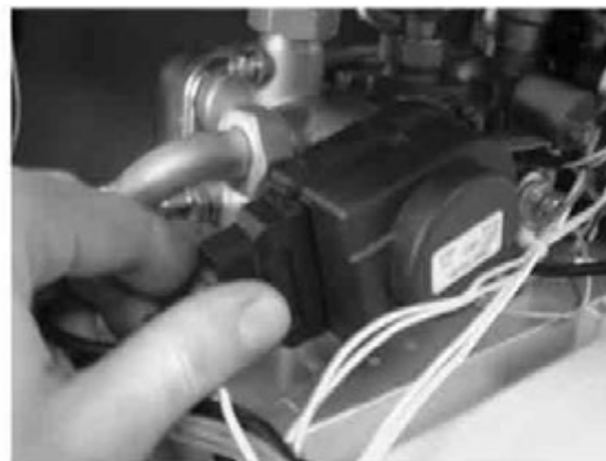
Bild 65: Anschluss Motorkopf
