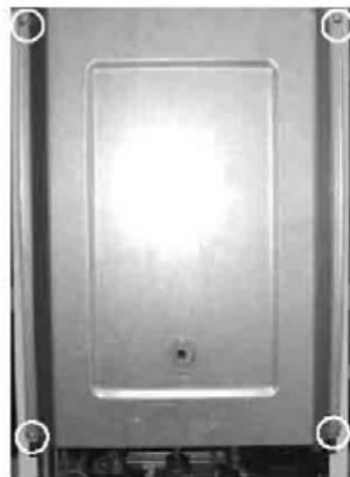
Bild 25: Befestigungsschrauben der Brennraumverkleidung
