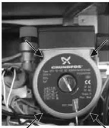
Bild 43: Befestigung Umwälzpumpe
