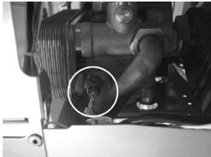
Bild 36: Warmwasserfühler
