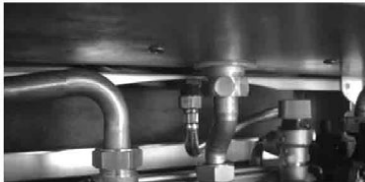
Bild 49: Plattenwärmetauscher nach links entnehmen
