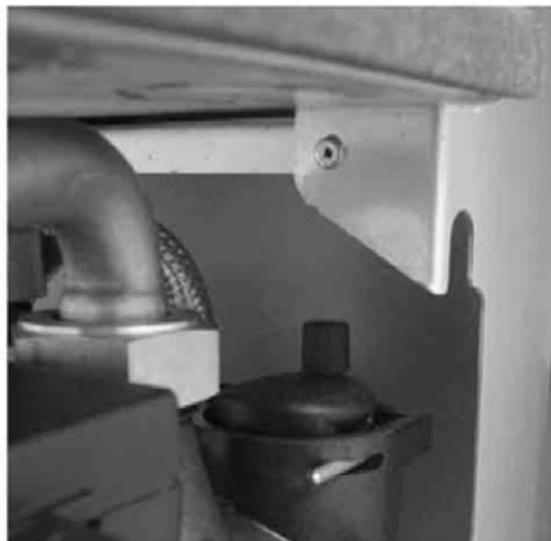
Bild 15: Automatischer Entlüfter
