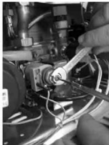
Bild 56: Einstellung Gasdruck
