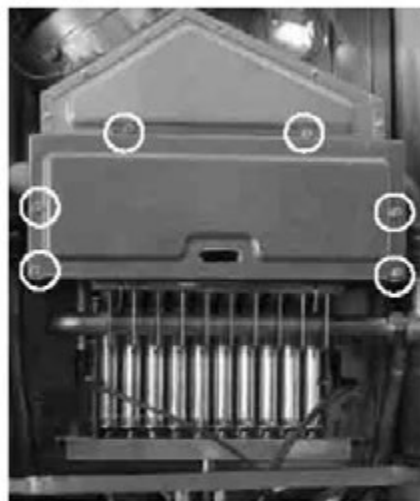
Bild 28: Befestigungsschrauben Brennraumabdeckung
