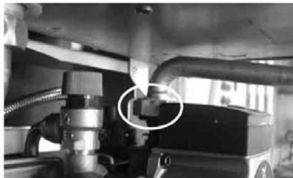
Bild 45: Anschluss Umwälzpumpe
