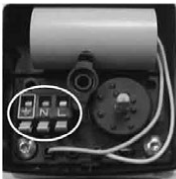
Bild 44: elektrische Anschlüsse Umwälzpumpe
